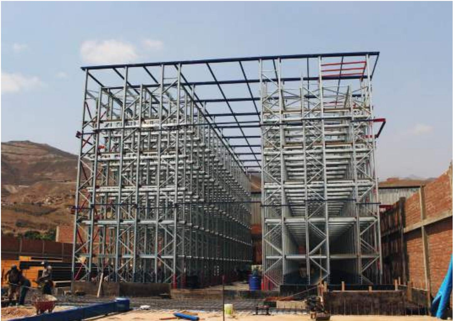
*Sistema drive in autoportante ha sido fabricado con acero galvanizado para soportar bajas temperaturas y corrosión.*
