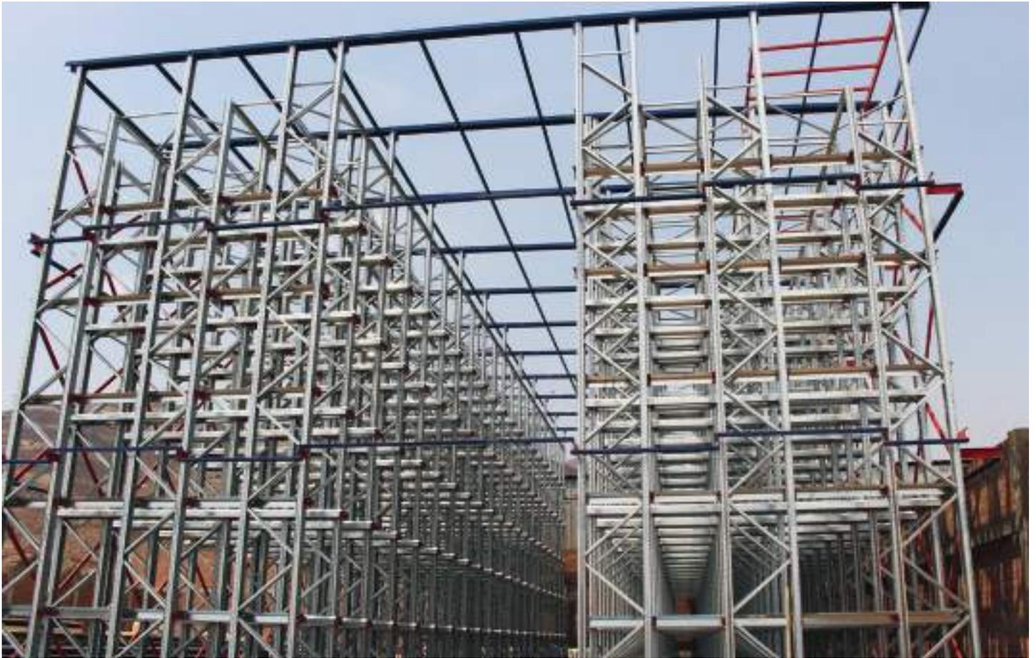
El sistema drive in autoportante tendrá 1200 posiciones y una altura total de 11502 mm.
